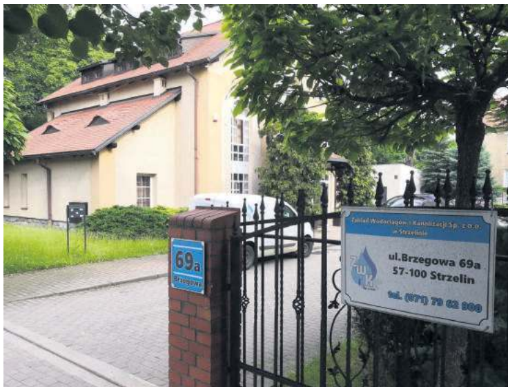
Przed strzelińskim Zakładem Wodociągów i Kanalizacji stoi w najbliższym czasie sporo trudnych i kosztownych zadań
