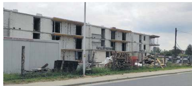
Przy ulicy Glinianej w Strzelinie trwa budowa trzykondygnacyjnego budynku z mieszkaniami z niskim czynszem
