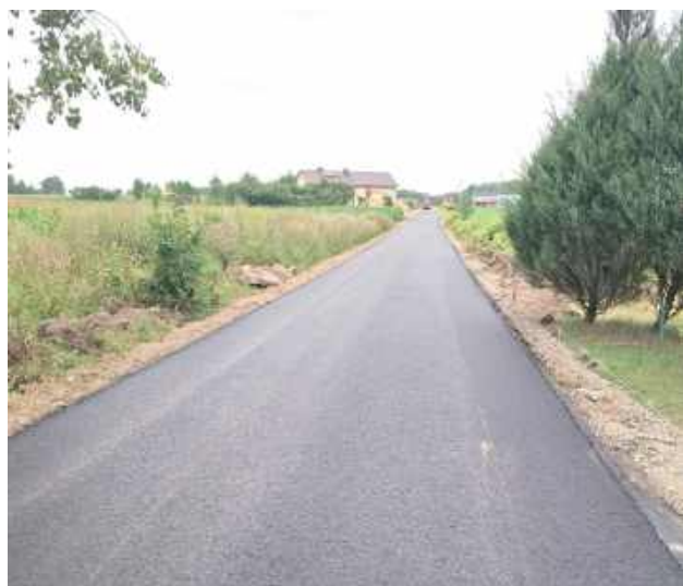
Przedsięwzięcie zmierza zgodnie z planem ku zakończeniu robót wykonawczych. Po wykonaniu poboczy kierowcy otrzymają równą, zabezpieczoną jezdnię o parametrach adekwatnych do ruchu na tym odcinku
