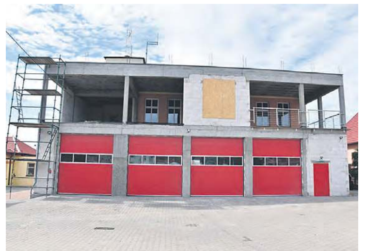
Jesienią ma być ogłoszony przetarg na dokończenie budowy.
