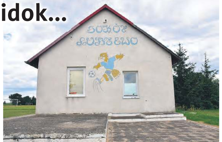
„Sokół Lubiewo” – jedyny, wyblakły ślad po piłkarzach na podniszczonym budynku.
