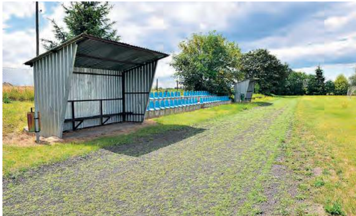
Na terenie boiska postawiono kiedyś dwie blaszane wiaty.
