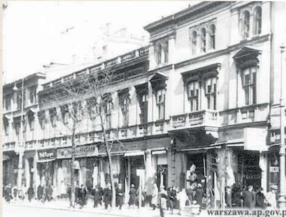
Plac na Marszałkowskiej 154 w Warszawie Bloch kupił w 1863 roku, zbudował tam okazałą willę, nierzadko nazywaną pałacem. Po jego śmierci została rozbudowana i straciła walor rezydencji. Zniszczona w czasie powstania, rozebrana po wojnie
