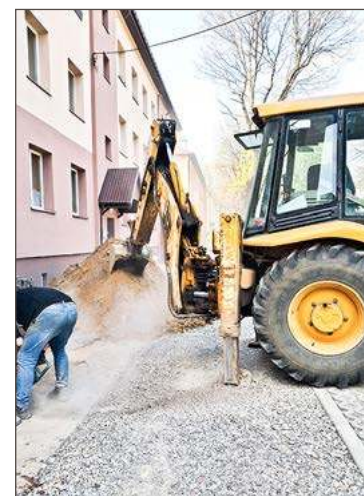
Prace wzdłuż Krakowskiej prace dobiegają końca.
