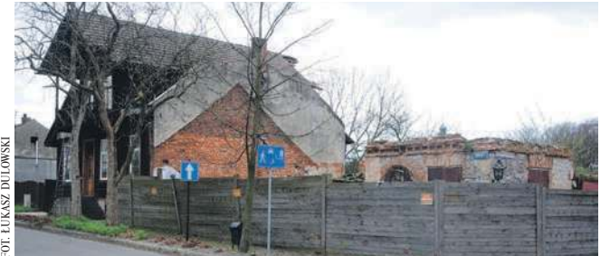
Po zabytkowych budynkach przy Rynku w Alwerni pozostały resztki murów, które straszą zza ogrodzenia
