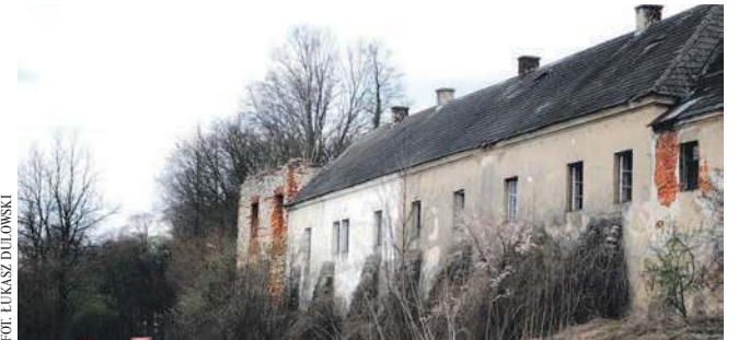
Na razie nadzieje na odbudowę dworu w Porębie Żegoty przysły jak bańka mydlana
