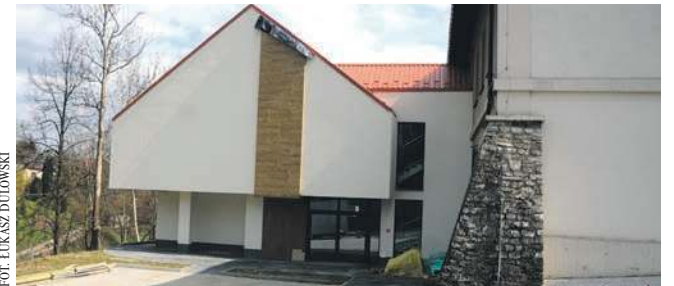
Nowa część z klatką schodową, dobudowana do starego budynku SP w Grojcu
