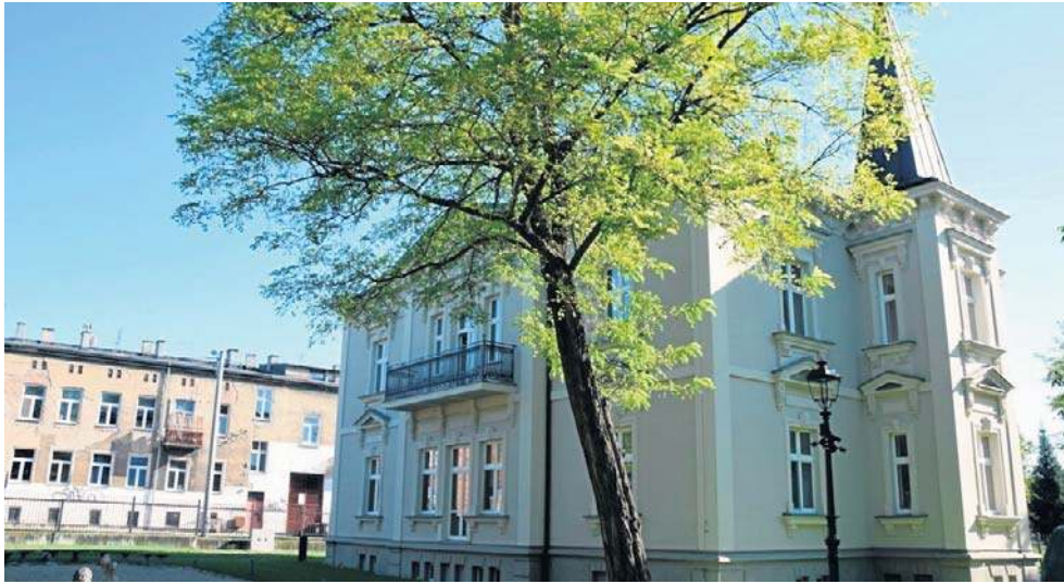
Piękny pałac w Częstochowie. Po remoncie to miejsce jest nie do poznania. Skala prac była ogromna - także we wnętrzach
