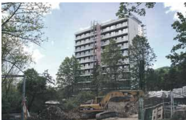
Prace przy dawnym sanatorium Hutnik w Szczawnicy idą pełną parą.
