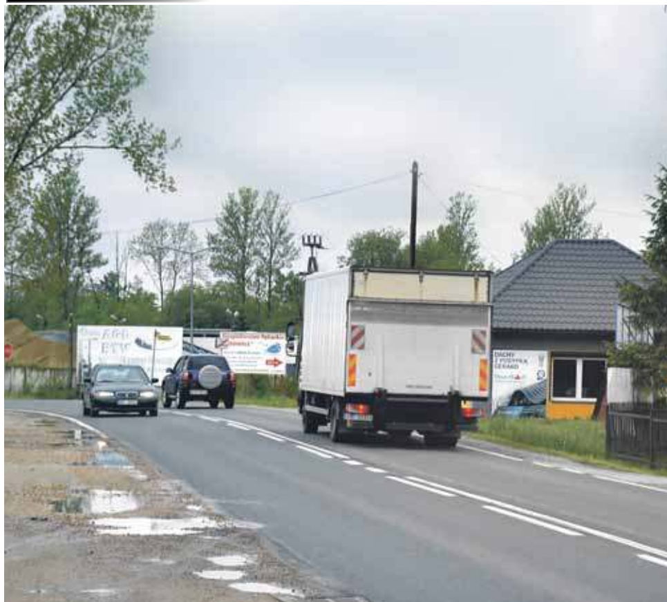
To najbardziej ruchliwa droga w Czarnym Dunajcu.
