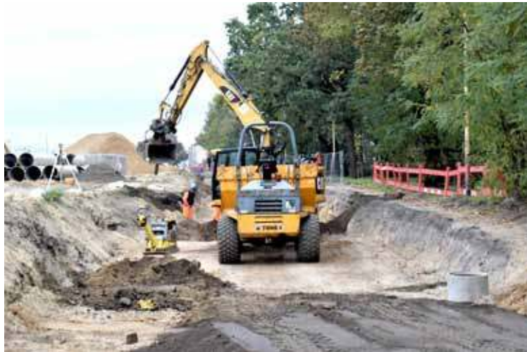
Przy ulicy Barnima od pewnego czasu trwają prace związane z budową największego w mieście parkingu
