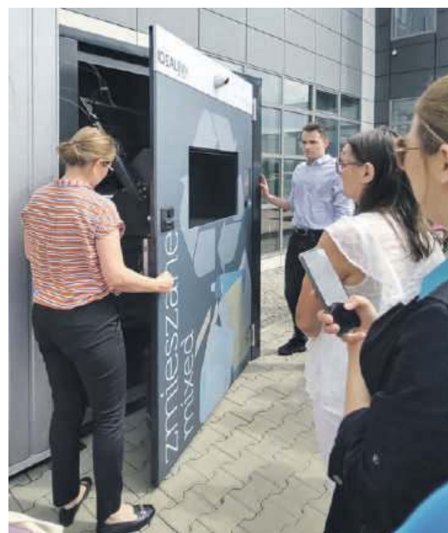
Przednia ściana kosza się otwiera tak, by firma wywożąca odpady bez problemu mogła wyjąć i opróżnić znajdujący się w środku pojemnik
