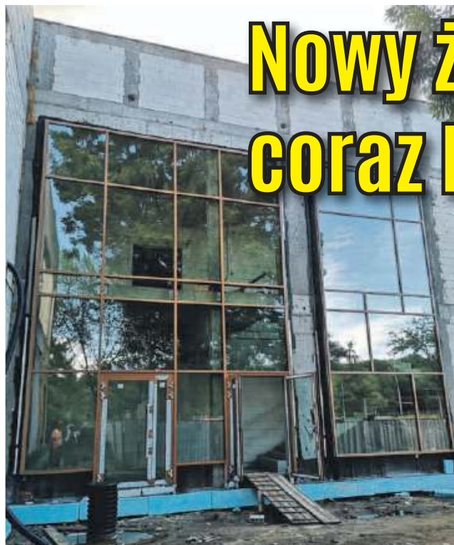
Żłobek budowany jest w nowoczesnym stylu
