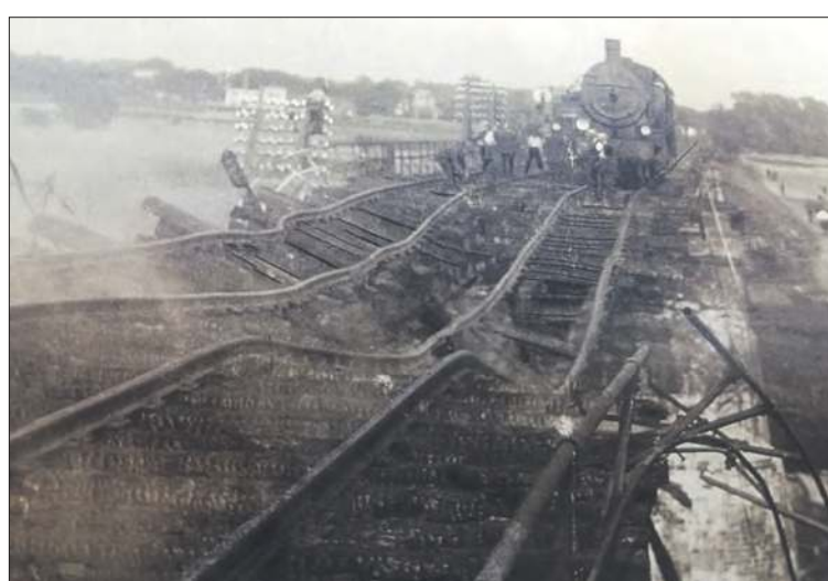
Zniszczony most na Odrze
