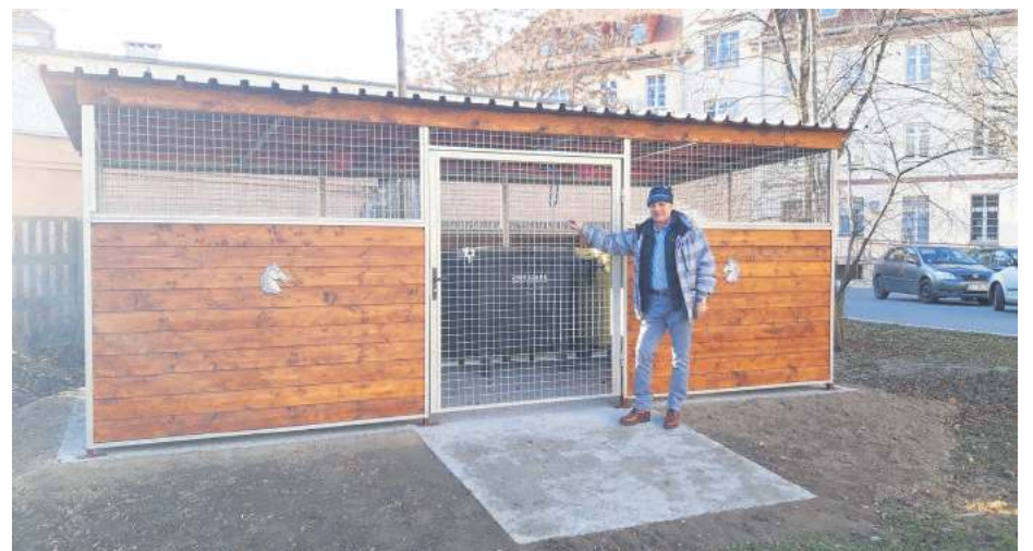
Tak wygląda wiaty wybudowana w ubiegłym roku przez Wspólnotę Mieszkaniową z ul. J. Piłsudskiego 4 w Strzelinie. Foto UMiG Strzelin
