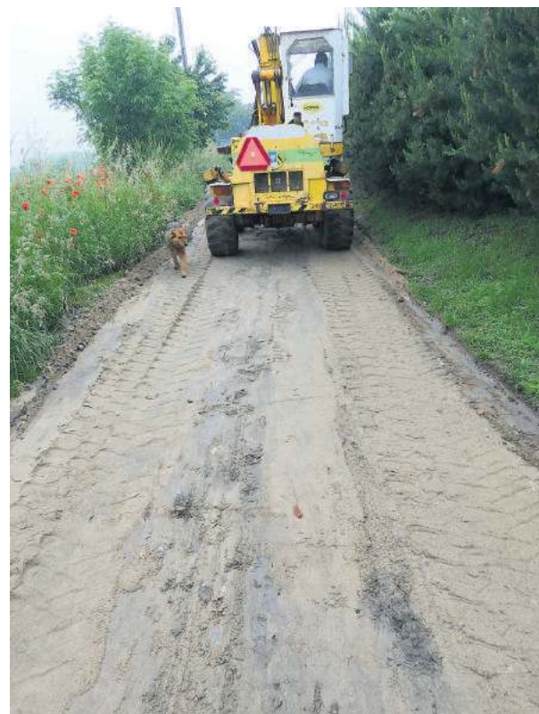
Naprawa wymytej drogi zaczęła się bardzo szybko, niemal natychmiast po interwencji naszego rozmówcy. Uważa on jednak, że wykorzystany do wyrównania i utwardzenia piasek w tym miejscu się nie sprawdzi
