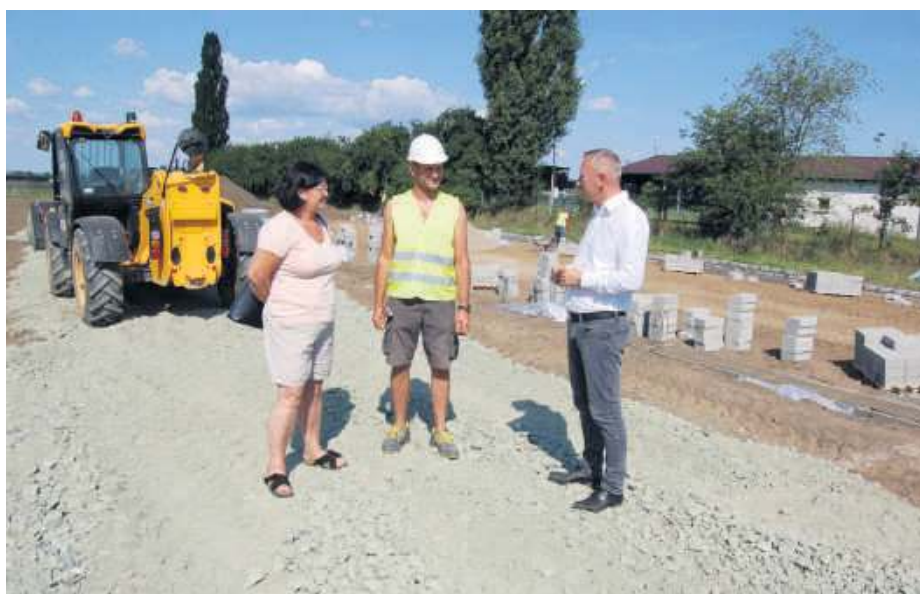
Wójt Tomasz Gracz (z prawej) i radna Małgorzata Krześcińska odwiedzili plac budowy
