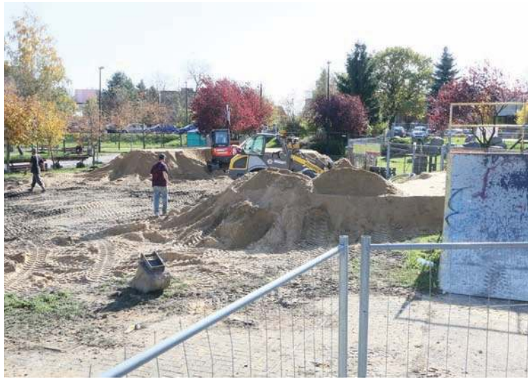
Wykonawca już przygotowuje grunt pod przyszły tor pumptrackowy
