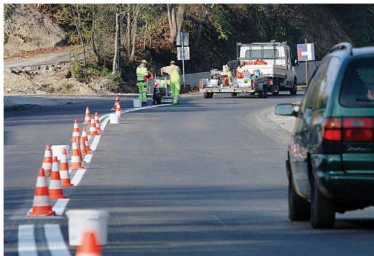
Przebudowa ulicy Kalinowszczyzna, a tym samym utrudnienia w ruchu, powinna się zakończyć przed zaplanowanym terminem
