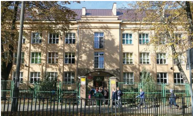
Przy SP nr 33 powstanie nowoczesny plac zabaw
