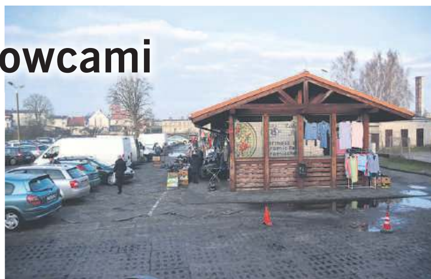
Wkrótce, w tym miejscu ruszą prace związane z przebudową targowiska i parkingu.
