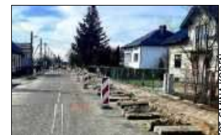
Trwa przebudowa ulicy Spółdzielczej w Kodniu
