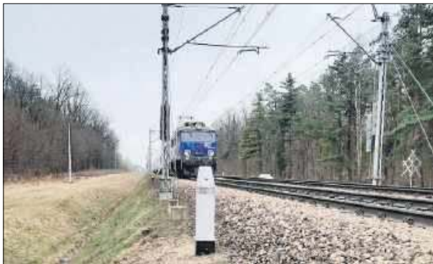
Na trasie kolejowej pomiędzy Białą Podlaską a Terespołem PKP PLK zainstalowało specjalne urządzenia, emitujące odgłosy m.in. wilków i kruków
