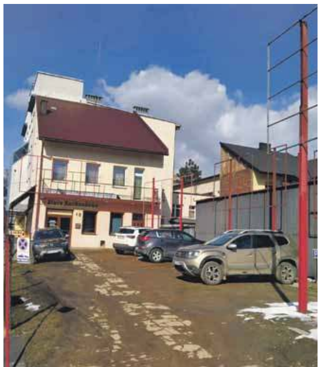
Taka instalacja pozostała po reklamach przy urzędzie.
