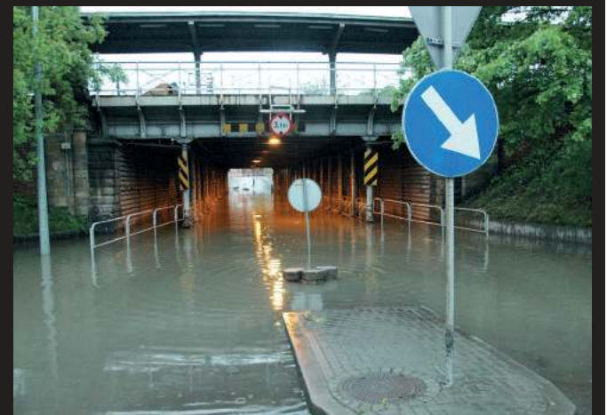
Wiadukt na Piaskowej był nieprzejezdny
