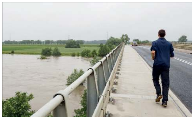
Kanał Ulgi podszedł pod most na Rudzkiej
