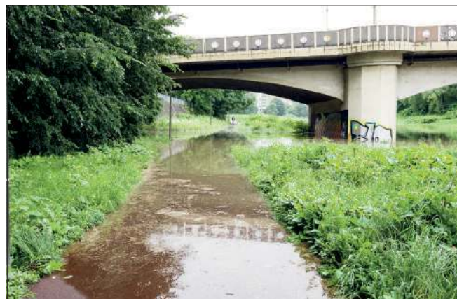
Ścieżka rowerowa biegnąca bulwarami stała się nieprzejezdna
