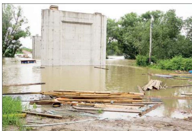
Ucierpiła budowa obwodnicy miejskiej
