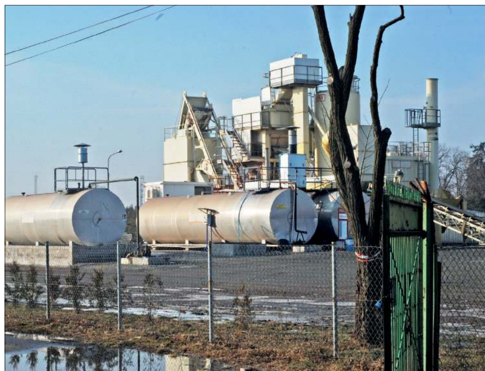
Tak wyglądała wytwórnia asfaltu na Płoni, kiedy jeszcze mogła tu produkować masy bitumiczne
