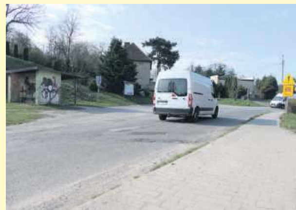
Remont tej drogi powiatowej uzyskał dofinansowanie
