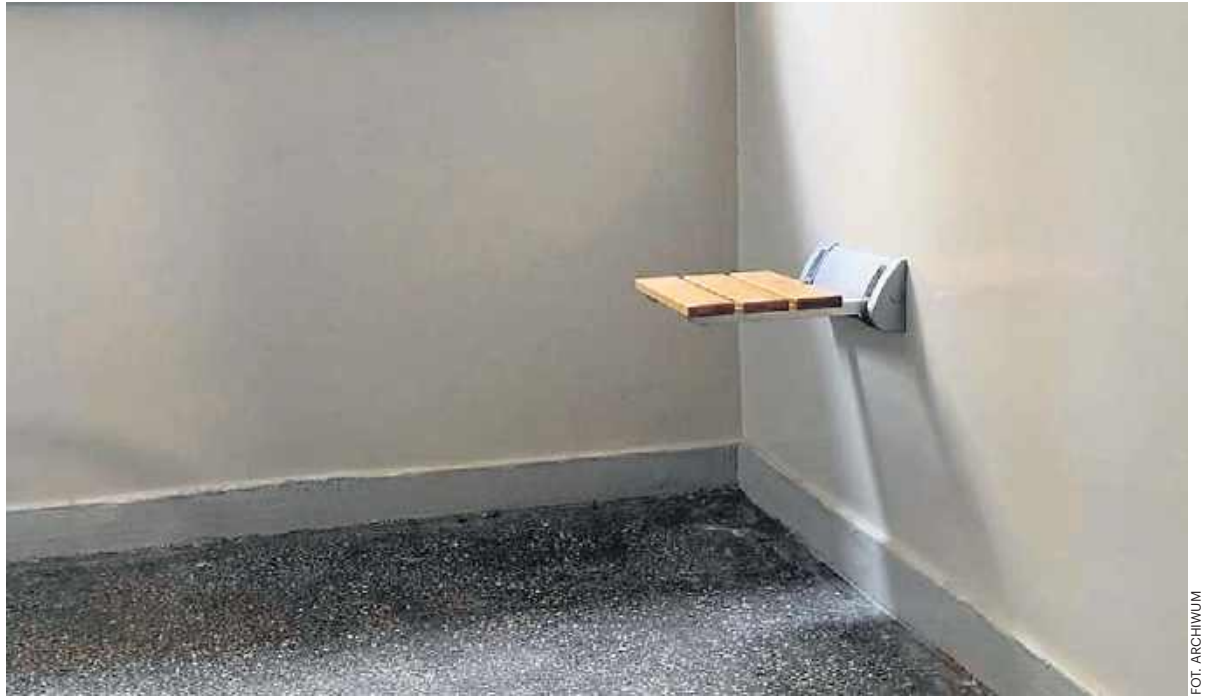
Spoczniki montowane są w blokach, w których klatki schodowe przeszły remont.
