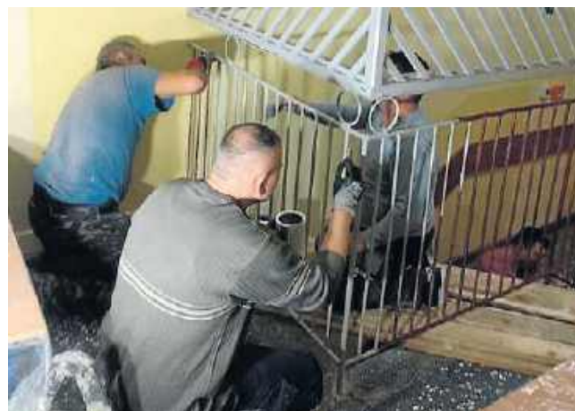
W gminie Bieliny rodzice przeprowadzili w szkołach drobne prace remontowe i porządkowe
