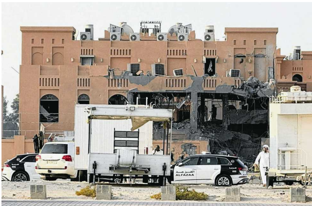
• Doha, 9 września 2025 r. Zniszczony budynek po izraelskim ataku na przywódców Hamasu FOT. REUTERS / IBRAHEEM ABU MUSTAFA
