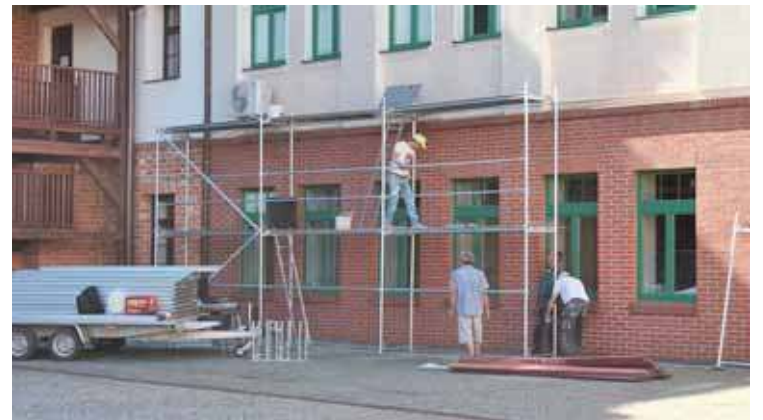
Roboty remontowe budynku Urzędu Miasta
