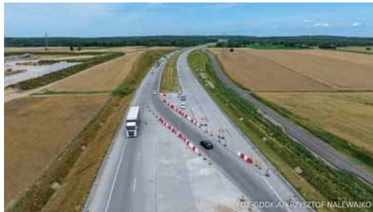
Rzut oka na trasę S7 udostępnioną dla ruchu, ale ciągle w budowie
