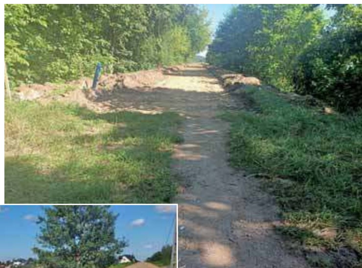
Nad zalewem trwają aktualnie prace ziemne poprzedzające budowę deptaku
