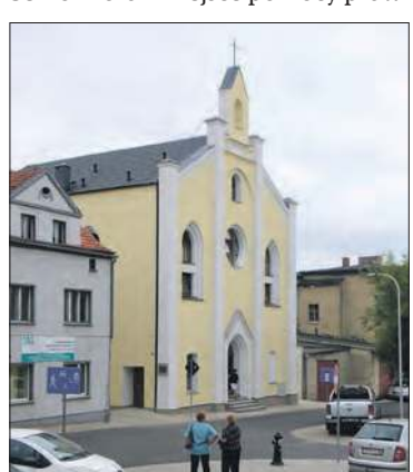
Dzięki zrealizowanej inwestycji zaniedbany budynek kościoła ewangelickiego nie tylko został odnowiony, ale i zyskał funkcje publiczne. Świątynia miała wiele szczęścia, większość protestanckich świątyń na ziemi prudnickiej została po II wojnie światowej zburzona.
