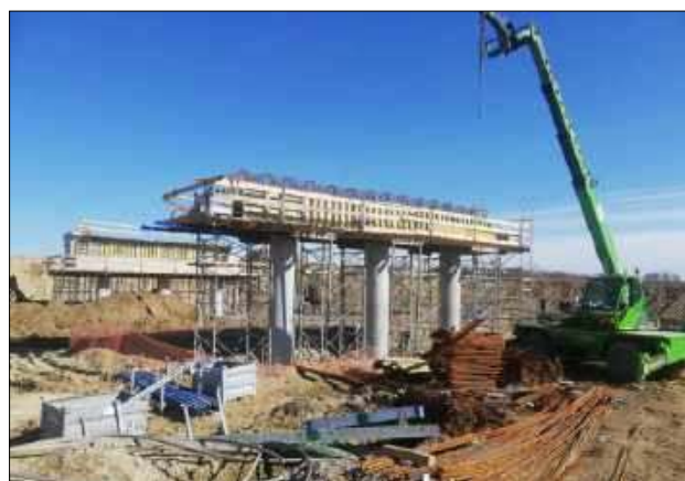
Zaawansowane prace trwają na odcinku Swory — Biała Podlaska (w. Ciciwór)
