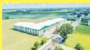
Nowoczesna hala przemysłowa o łącznej powierzchni 3 150 m 2 usytuowana na działce hektarowej w miejscowości Wołyn, 885 851 172
