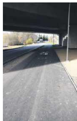
Nowa nawierzchnia drogi powiatowej
