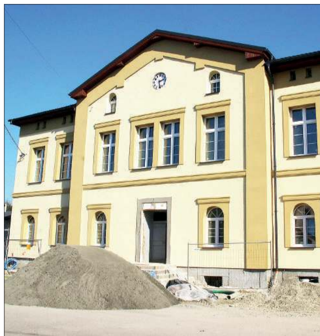
Tak obecnie prezentuje się budynek pietrowickiego dworca
