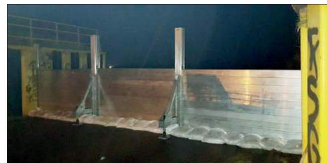
Ostatni raz szandory w Turzu ustawione zostały w październiku 2020 roku, kiedy nad regionem przechodziły obfite opady deszczu
