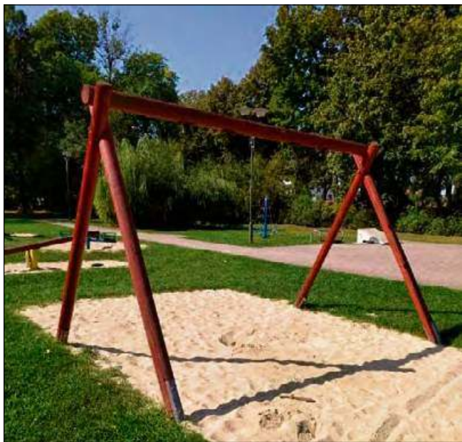
Rodzice apelują o naprawę lub zabezpieczenie urządzeń.
