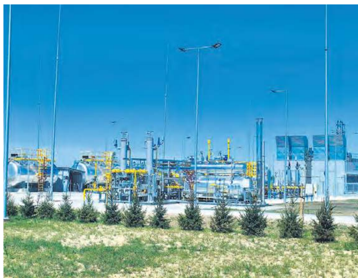
Elektrownie już produkują prąd. Kiedy złoża gazu się skończą, modułową konstrukcję można rozebrać i przenieść w inne miejsce.
