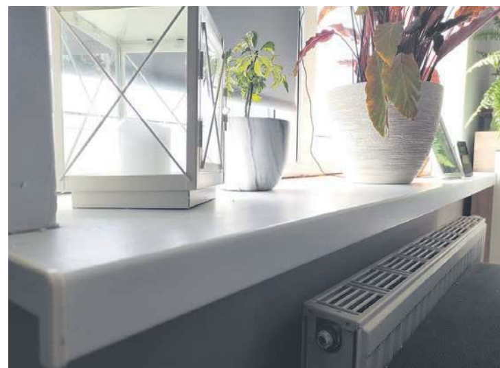
Klasyczny, kwadratowy parapet PCV. Jego zalety to niska cena i trwałość.
