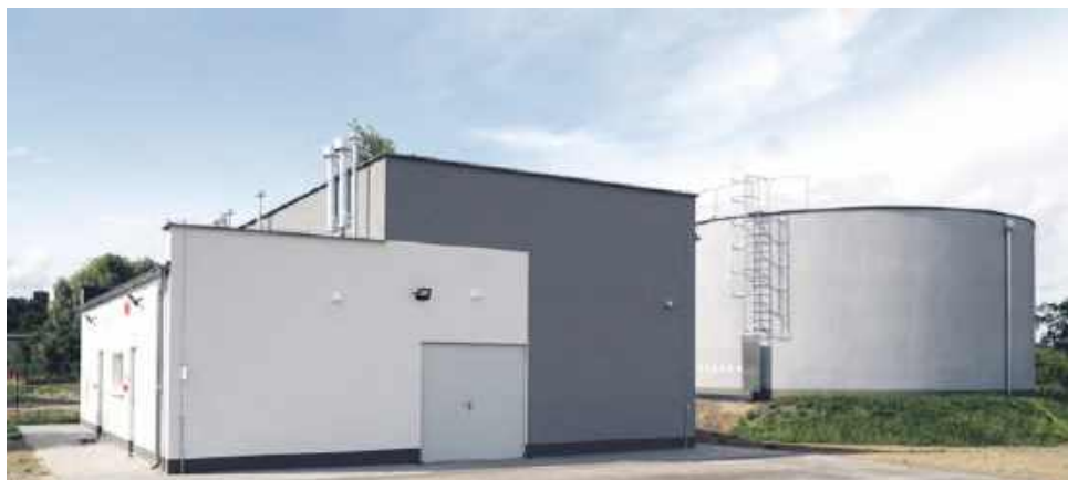
Stacja Uzdatniania Wody w Sobocisku
