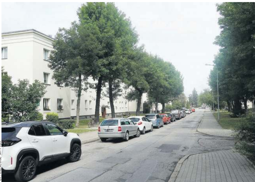
Miasto na realizację tego zadania związanego z remontem ulicy Wolności otrzymało dofinansowanie z Rządowego Funduszu Rozwoju Dróg w wysokości 2,8 mln zł.
