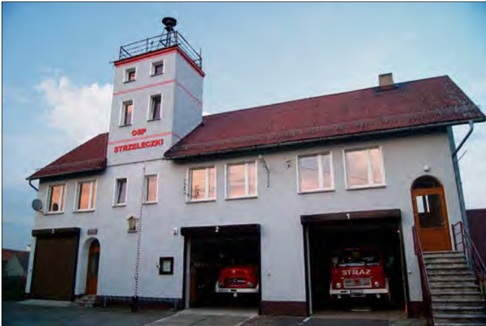
Tak prezentowała się remiza przed termomodernizacją.
