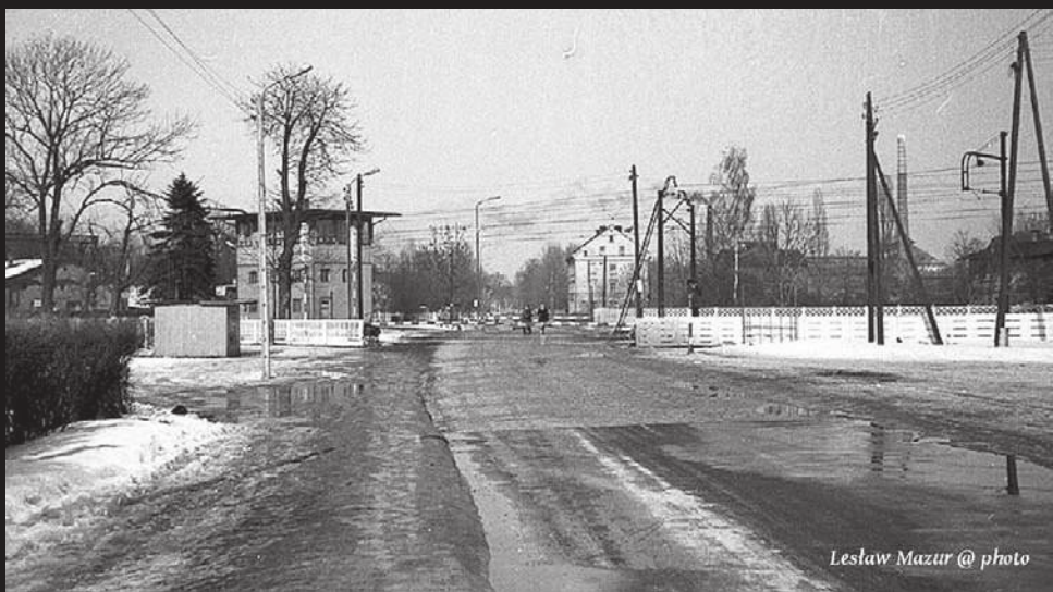
1967 - przejazd kolejowy, po lewej stacja osobowa, na pierwszym planie kiosk drewniany pana Henryka Otrębskiego, przy torach wysoki budynek to nastawnia kolejowa - w tym budynku były korby, którymi podnoszono szlabany
