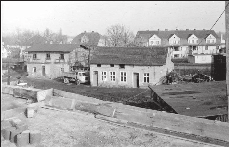
1974 - widok z wiaduktu w kierunku ul. Różanej
