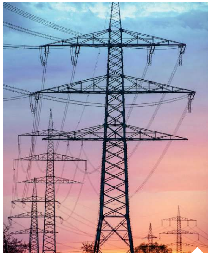
Budowa nowoczesnych linii przesyłowych zapobiega awariom wywołanym przez skrajne zjawiska pogodowe | fot. Pixabay/d
