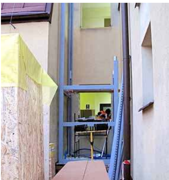
Trwa budowa windy.
