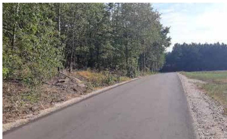
Gmina Baranowo – Usprawnienie połączeń komunikacyjnych poprzez przebudowę dróg gminnych Zawady-Żabiocha-Karaska, Rupin-Cierpięta-Rycica oraz Cierpięta-Czechronka
