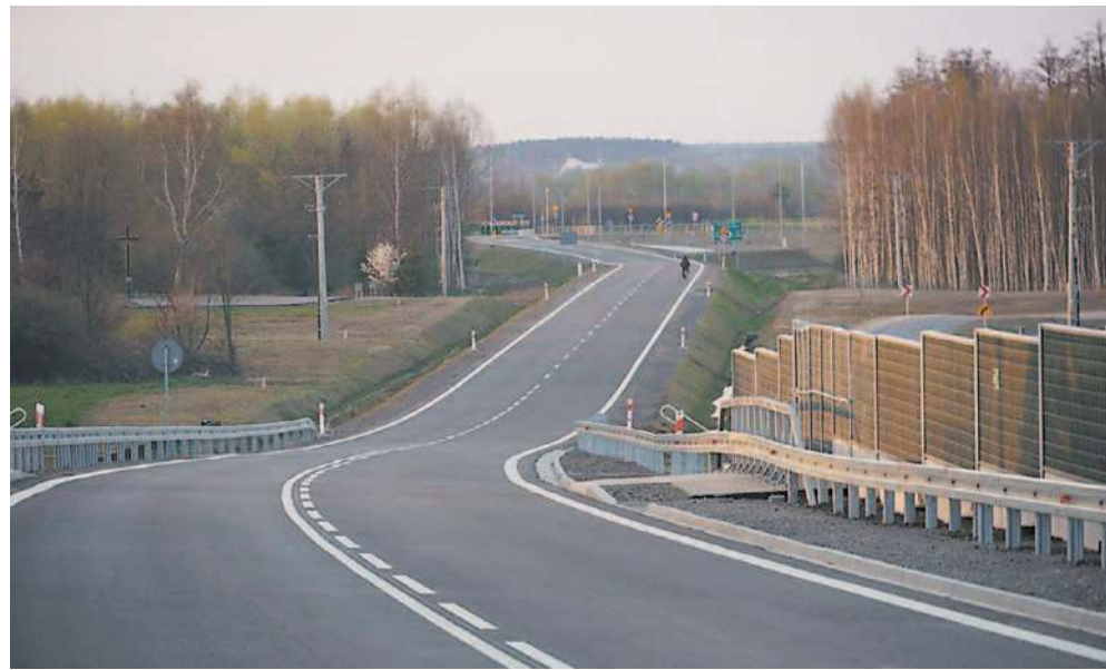
Obwodnica Stalowej Woli i Niska w ciągu drogi krajowej nr 77 obejmuje odcinek od Stalowej Woli – skrzyżowanie Trasy Podkarpowej z ul. Chopina – do połączenia z realizowaną drogą ekspresową S19 na terenie gminy Nisko. Na zdjęciu odcinek między Woliną a rondem na DK19 między Niskiem a Zarzeczem
