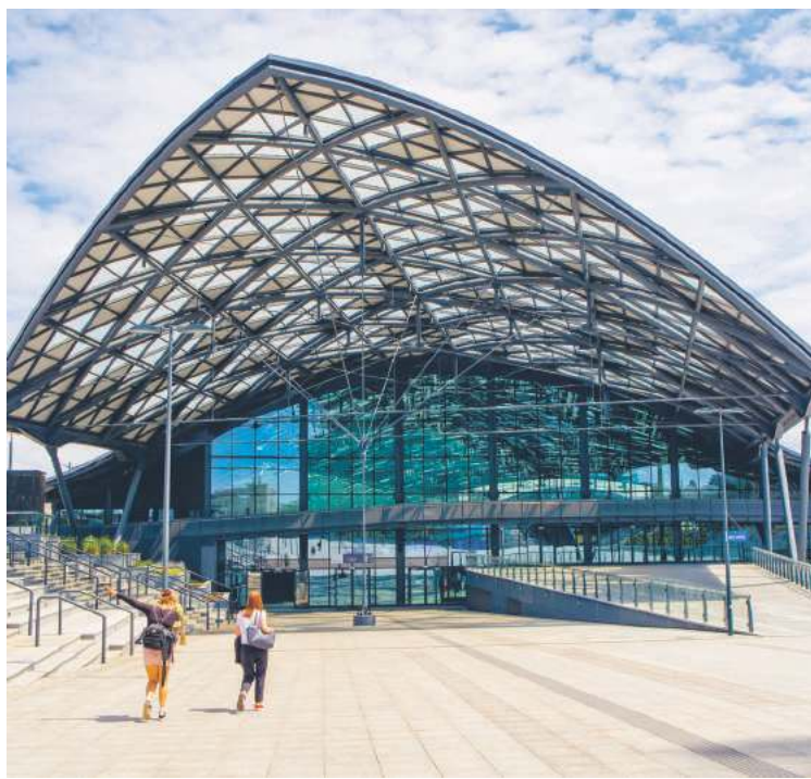
1,3 mld zł otrzyma Łódź na budowę tunelu średnicowego, który połączy dworce Łódź Fabryczna i Łódź Kaliska | fot. Jan Środa/Gazeta Polska
