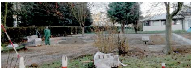
Między ul. Sikorskiego i Batalionów Chłopskich powstanie 7 miejsc parkingowych
