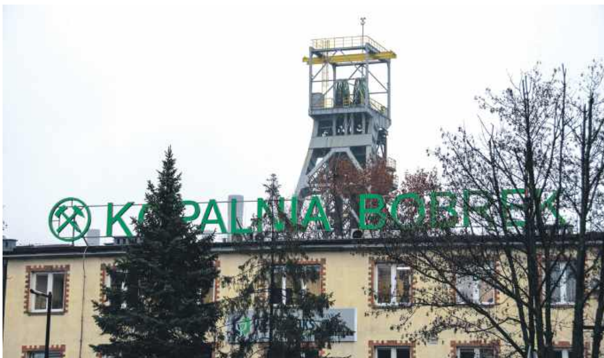
Kilkuletni proces likwidacji kopalni siłami załogi będzie możliwy jeśli zostaną na to zapewnione środki finansowe
