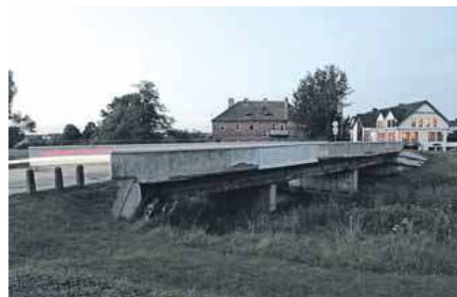
Projekt przebudowy, a właściwie budowy zupełnie nowego mostu wykonano już w 2011 r. I na kilka lat sprawa została odłożona na półkę
