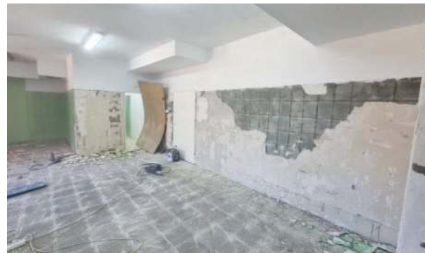
Remont pomieszczenia pracowni tomograficznej
