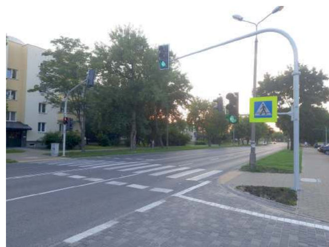
W tym miejscu często dochodziło do potrażeń pieszych, nawet śmiertelnych. teraz piesi będą mogli bezpiecznie przejść przez ruchliwą ulicę
