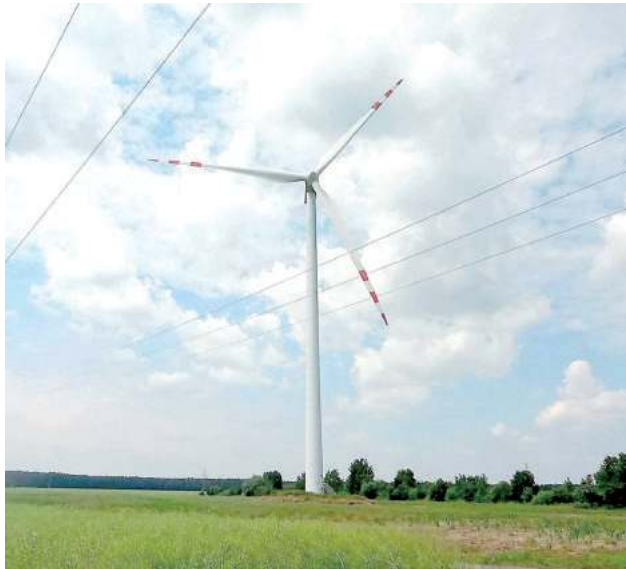
Wiatraki stoją w pobliżu DW 813. Kontrola Głównego Inspektoratu Nadzoru Budowlanego w Warszawie wykazała, że są za niskie o około 20 metrów
