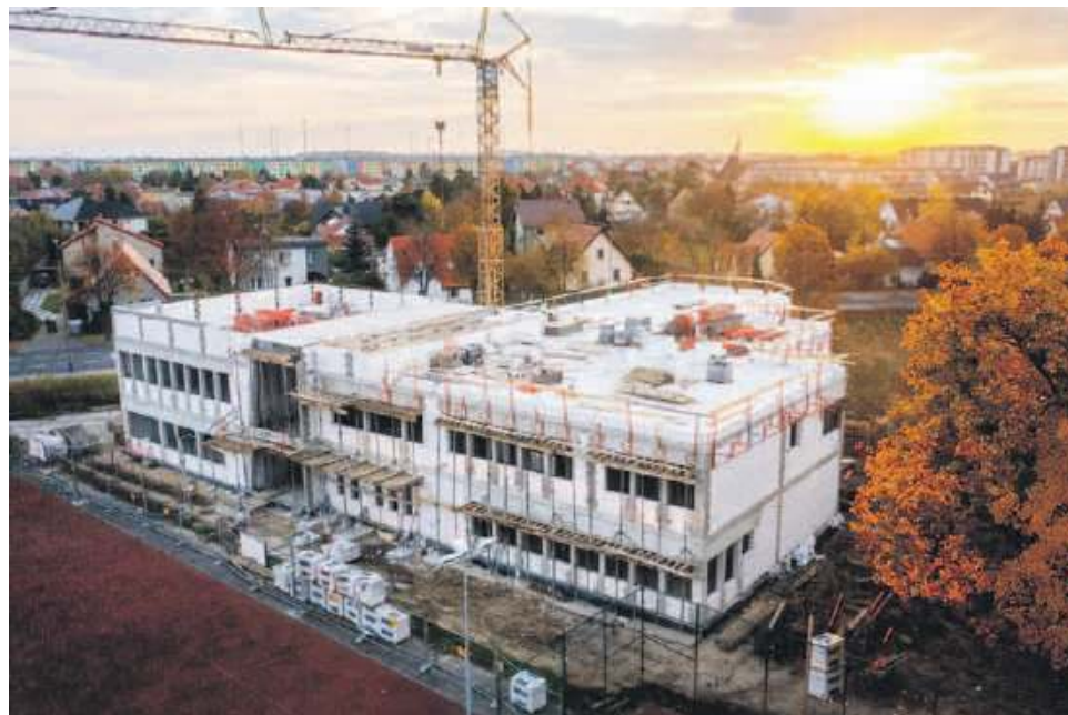
Plac budowy profesjonalnych warsztatów szkolnych
