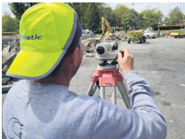
Obecnie na placu budowy trwają prace ziemne, podczas których często wykorzystywany jest niwelator do dokładnego określenia wysokości
