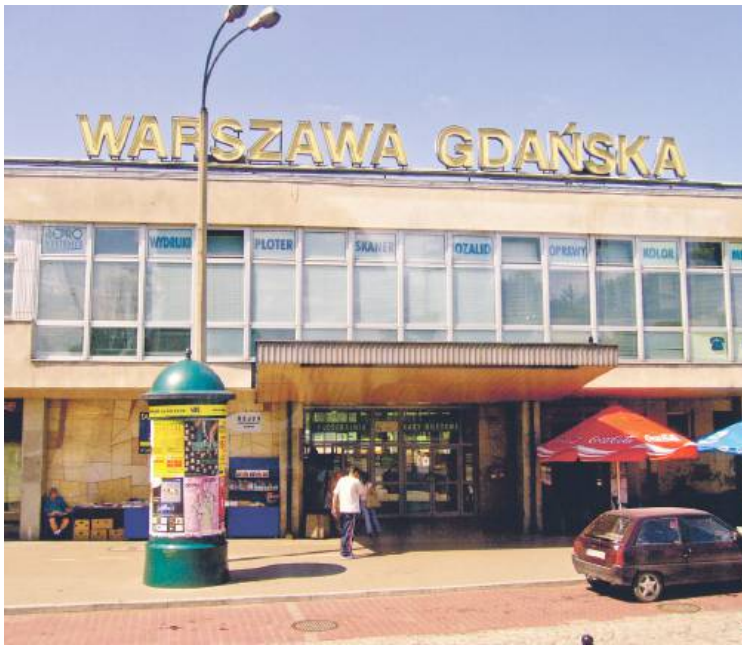
Warszawa Gdańska będzie miała nowy peron oraz przejście podziemne. Kolejarze zaplanowali budowę tymczasowego peronu nr 5 | fot. Wikipedia/d
