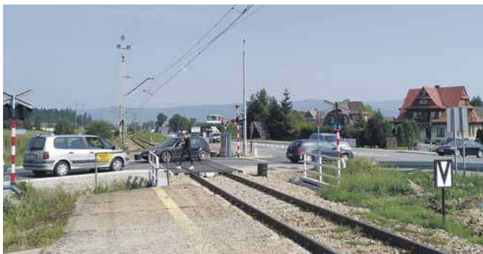
W pierwszej kolejności odbył się remont torowiska. Na razie piesi muszą korzystać z tymczasowego przejścia tuż obok bardzo ruchliwej drogi.
