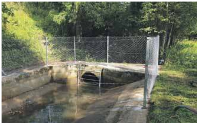
Rurociąg zabezpieczony kratą. Pracownicy zamontowali też ogrodzenie.
