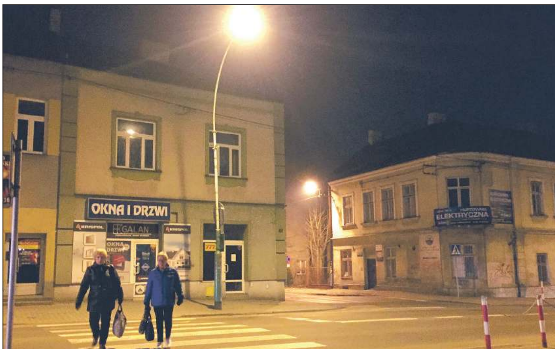
Przejście na Rzeszowskiej jest jednym z lepiej oświetlonych w mieście, ale i tak jest niebezpieczne ze względu na położenie. Jadąc od centrum znajduje się ono zaraz za górką, spod której niewiele widać. Lepiej tu zwolnić.
