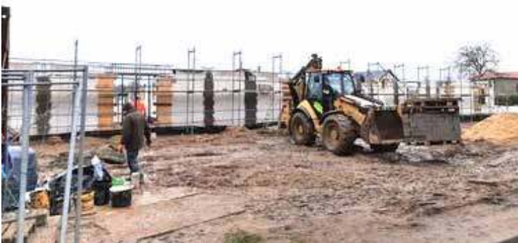
Budowa przedszkola w Dolicach
