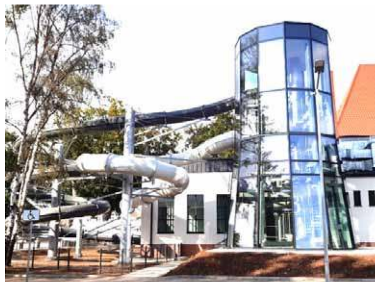
Dzięki termomodernizacji budynku zmniejszono zapotrzebowanie na ciepło i energię elektryczną.
