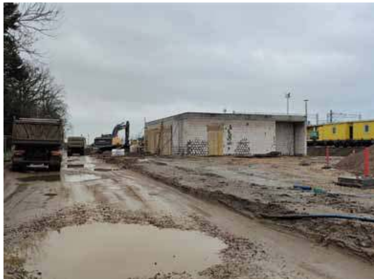
Montowana jest instalacja elektryczna w nowym budynku socjalno-usługowym, który w najbliższym czasie zostanie otynkowany.
