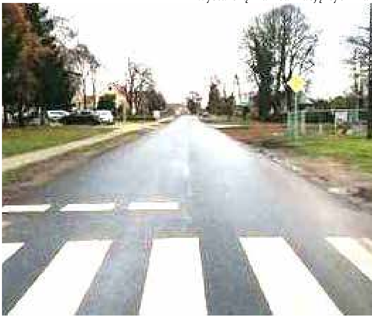
Nowa droga w Strzebielewie.
