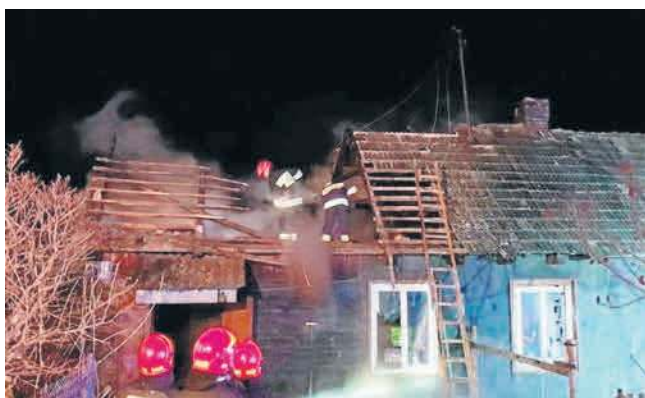
Nocny pożar w Modrzejowicach gasiło siedem zastępów zawodowej i ochotniczej straży pożarnej - w sumie 33 strażaków.
