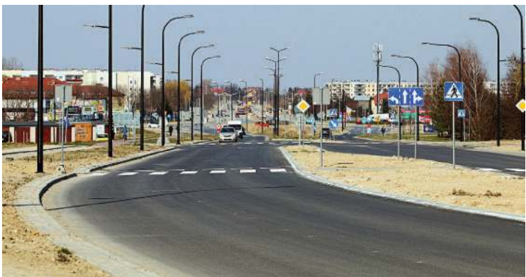
Prace na ul. Kusocińskiego są już na ukończeniu
