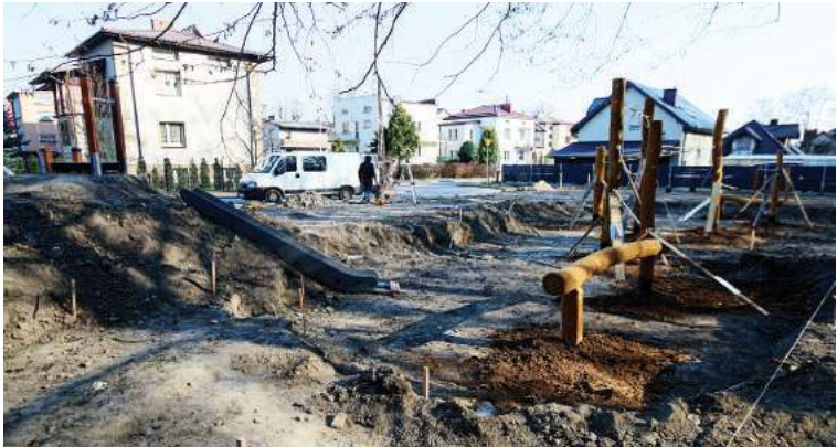
Budowa Ogrodu Zabaw już się rozpoczęła
